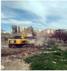
Gecekondu yıkım esnası
