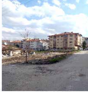
Gecekondu yıkım sonrası
